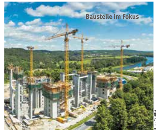
Montage der Stahlbetonbauten 2015
