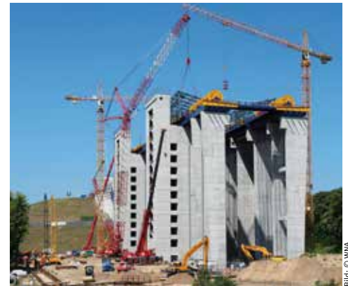
Einhub eines Elements der Seilrollenhalle
