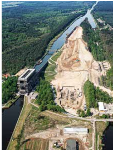
Herstellung der Baugrube neben historischem Hebewerk
