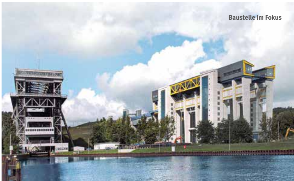
Historisches Bauwerk neben dem Neubau im September 2020, beide sind noch etwa fünf Jahre parallel in Betrieb.
