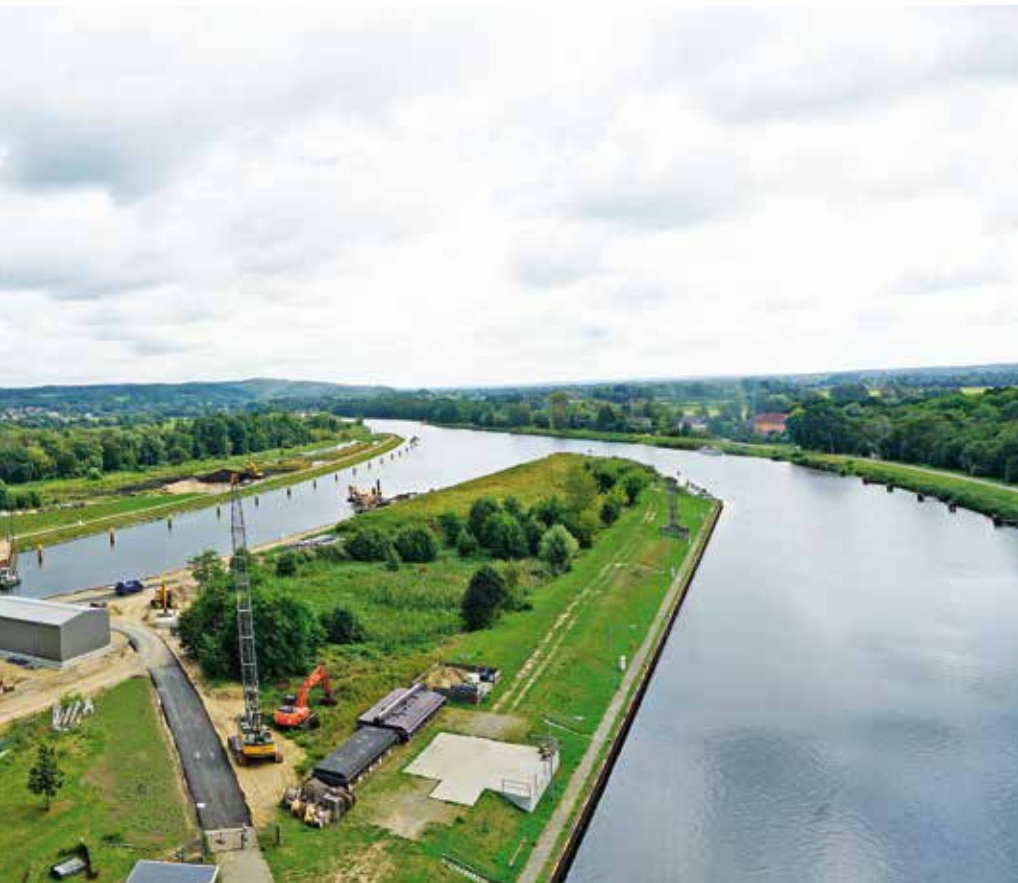
Letzte Außenarbeiten rund um den Neubau
