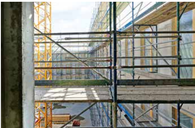
Sichere Einrüstung für Rohbau MK1 und Arbeiten auf Geschossebene
