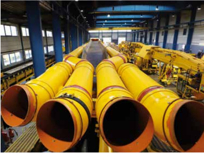
Die KG500-Rohre wurden weitestgehend oberhalb der RM 900 S entlanggeführt.
