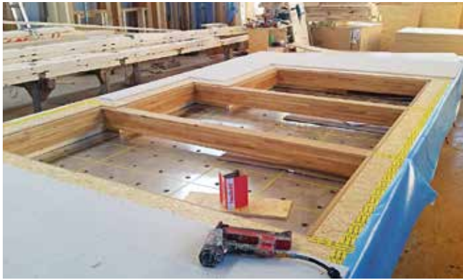
In die Konstruktion integrierten die Holzbau-Experten eine tragende Pfosten-Riegel-Fassade aus Eiche.
