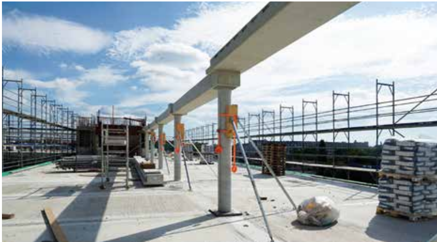
Stahlbetonkonstruktion als Auflager für die Holz-Hybrid-Deckenplatten
