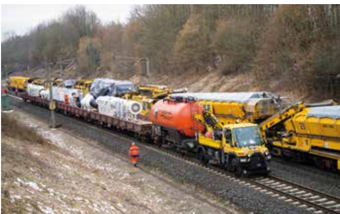
Der Arbeitszug mit der Entstaubungsanlage von CFT beim Pilotversuch vor dem Kalbachtunnel im März 2019. Im Hintergrund: die abgedeckten MFS-Wagen von SPITZKE.
