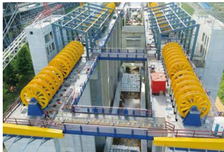
Blick in die Achse des Hebewerks
