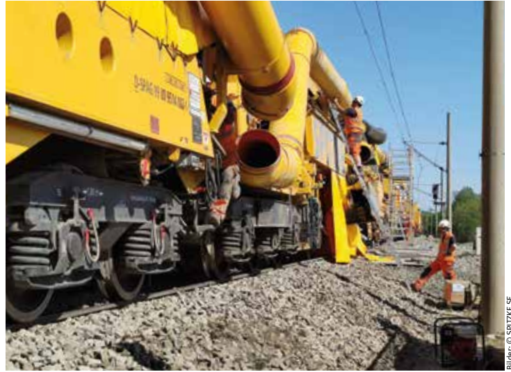
Ausrüstung der RM 900 S mit der Staubabsaugung für den ersten Einsatz auf der SFS 4080 im April 2020
