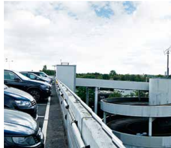
EDGE Suedkreuz entsteht auf engem Raum.
