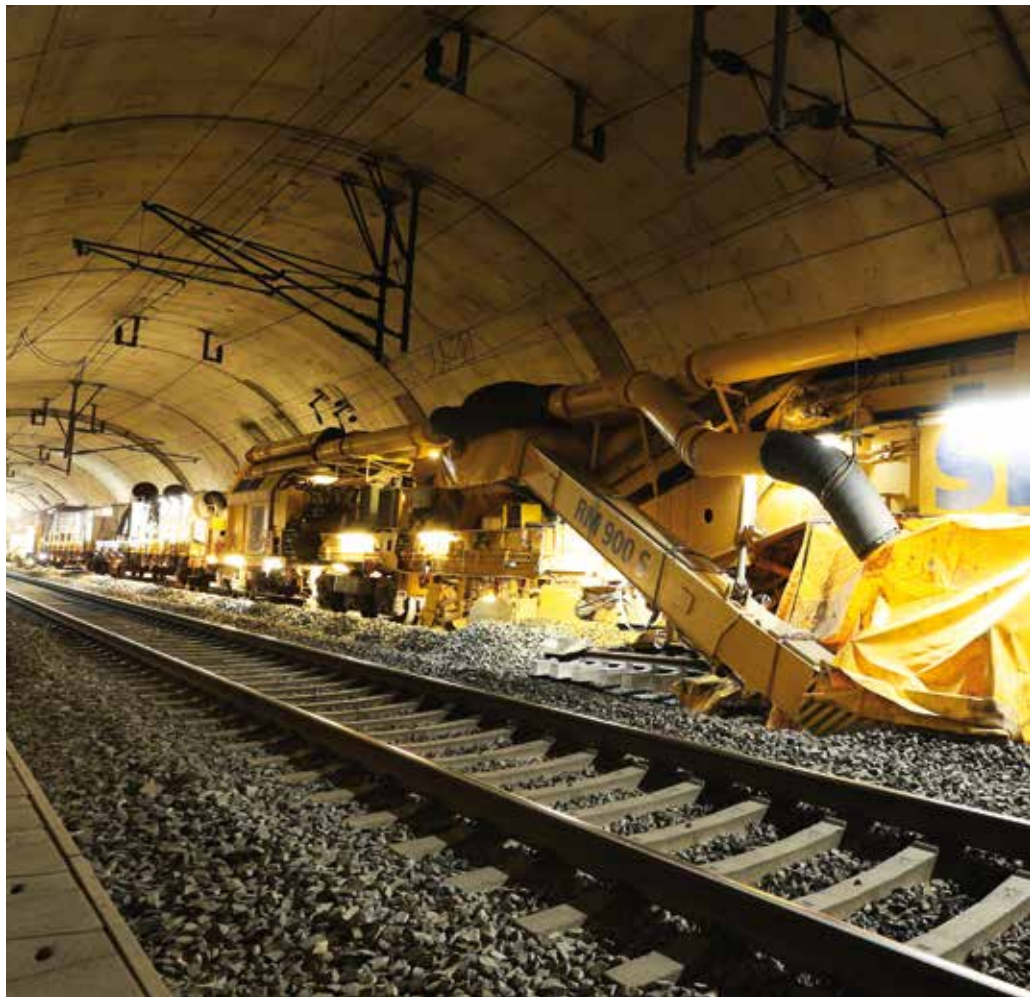
Die mit der Staubabsaugung ausgerüstete RM 900 S im Pulverdinger Tunnel
