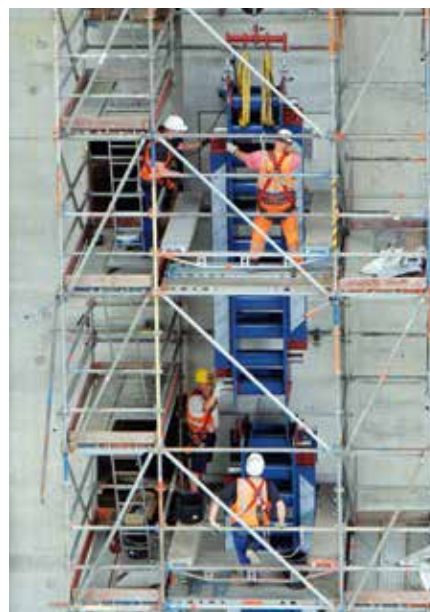
Montage der Triebstockleiter
