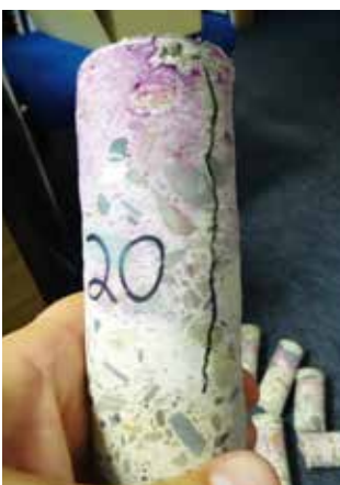
Sichtbare Risstiefe an einem Bohrkern
