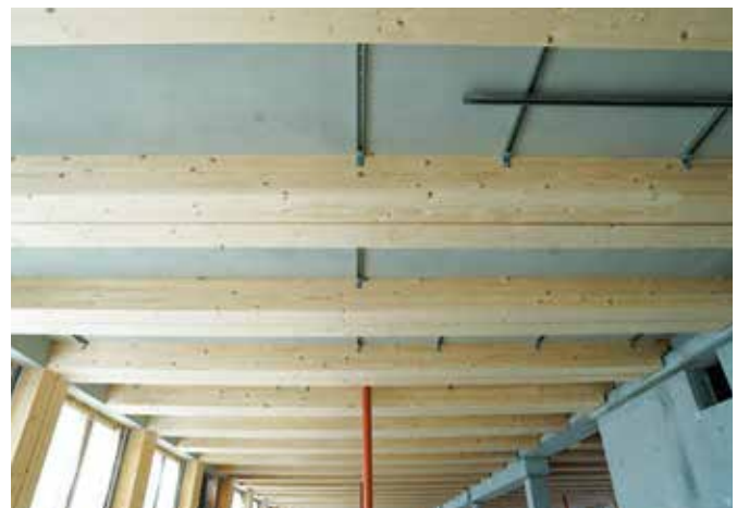
Deckenkonstruktion mit Regenwasserableitung
