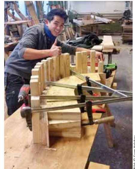
Die Herstellung der Deckenaufleger für die Rundungen
